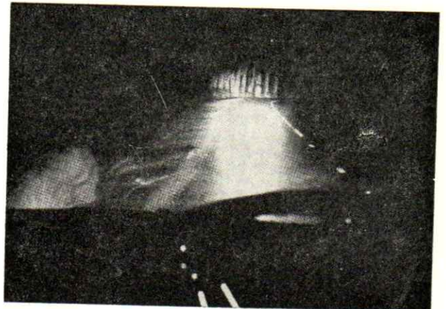
ציור 6: הארת הדרך באמצעות נורת יודיד-טונגסטן חדישה של „מאצדה”. ההבדל במידת ההארה בין הנורה הרגילה (למעלה) ובין נורת „מאצדה” — נראה בבירור
